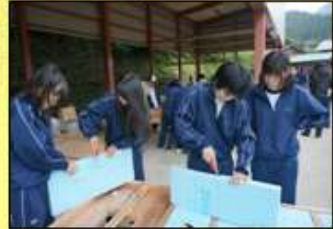
断熱材の加工
