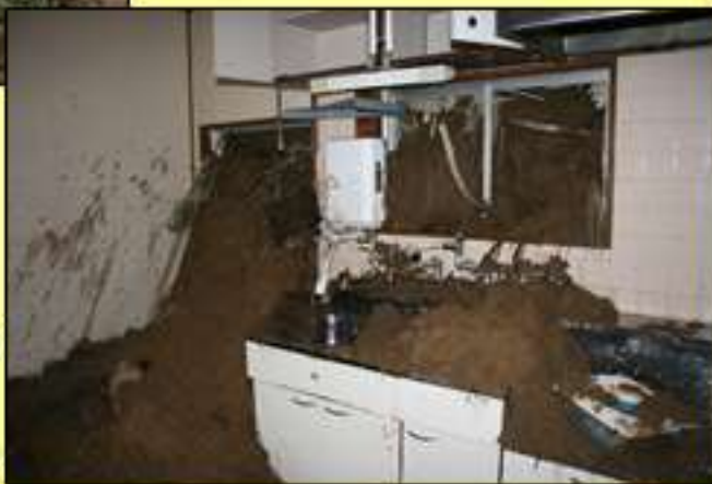
校長公舎内部の様子 (平成21年8月11日昼撮影)
