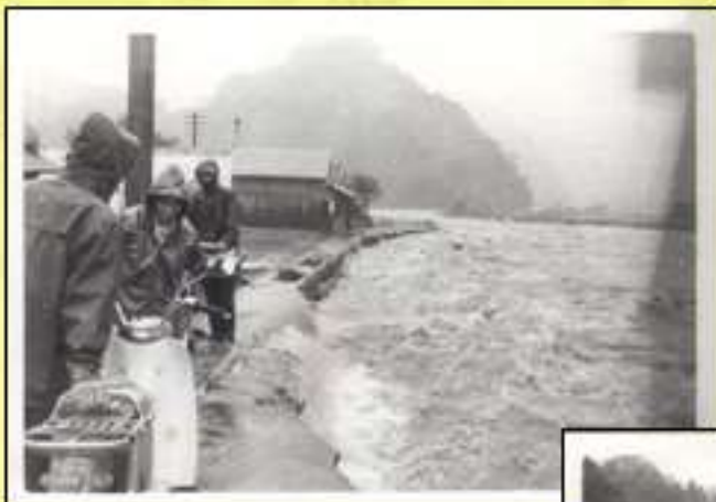
室橋流出後の城宮方向 (町史掲載写真)
