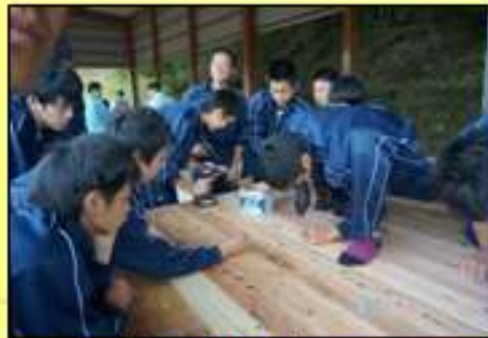
インパクトドリルで加工
